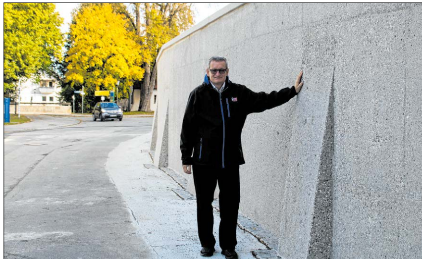
▲ Pfarrrer Leander Mikschl ist über den Planungen zur Sanierung der Friedhofsmauer in Traubing fast zum Baufachmann geworden. Foto: Reitzig
