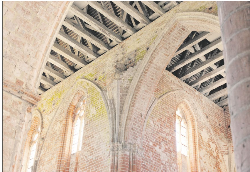
▲ Ein Blick in den Dachstuhl der gotischen Klosterkirche von Chorin.
