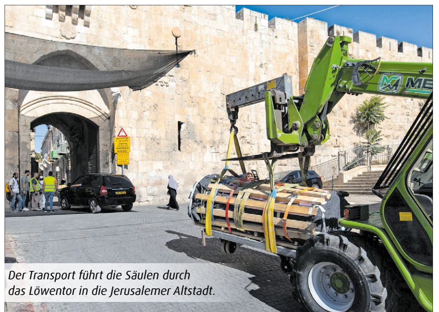
Vorsichtig wird die Säule verpackt und von schwerem Gerät angehoben.
