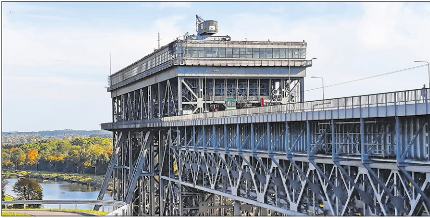
▲ Das imponierende stählerne alte Schiffhebewerk wurde zwischen 1926 und 1934 gebaut. Es diente dem Drei-Schluchten-Hebewerk am Jangtse in China als Vorbild.
