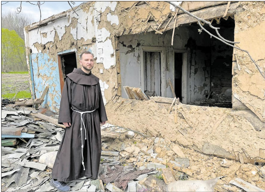
▲ Ein Ordensmann steht vor einem durch Beschuss zerstörten Haus in der Nähe der ostukrainischen Stadt Charkiw. Fotos: Kirche in Not
