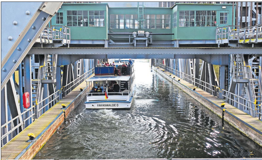
▲ Ein Schiff überbrückt im alten Hebewerk die 36 Meter Höhenunterschied auf dem Oder-Havel-Kanal.
