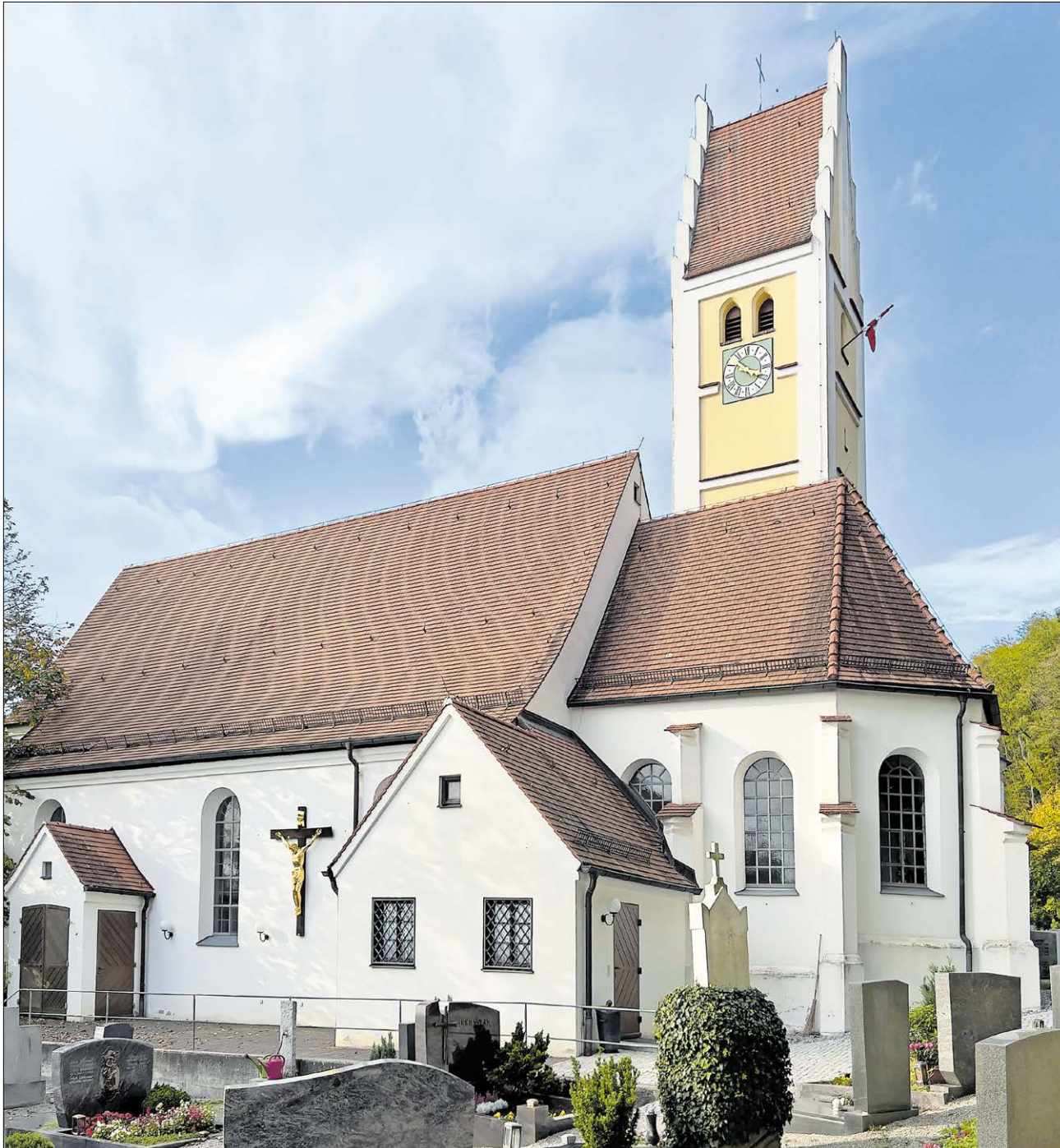
▲ Die Kirche St. Johannes Baptist und Maria Magdalena im Affinger Ortsteil Mühlhausen wurde bereits im 12. Jahrhundert urkundlich erwähnt. Der heutige Chor und der Turm stammen wohl aus dem 15. Jahrhundert und wurden 1776 umgestaltet. Das Langhaus drohte abzurutschen und wurde 1989 neu errichtet. Der Saalbau mit eingezogenem Chor unter einer Stichkappentonne besitzt einen nördlichen Satteldachstuhl mit Treppengiebeln. Foto: Reinthaler
