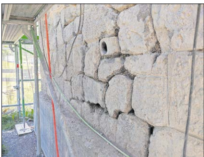
▲ Die mächtigen Natursteinblöcke stammen aus einer nahen Bergflanke.
