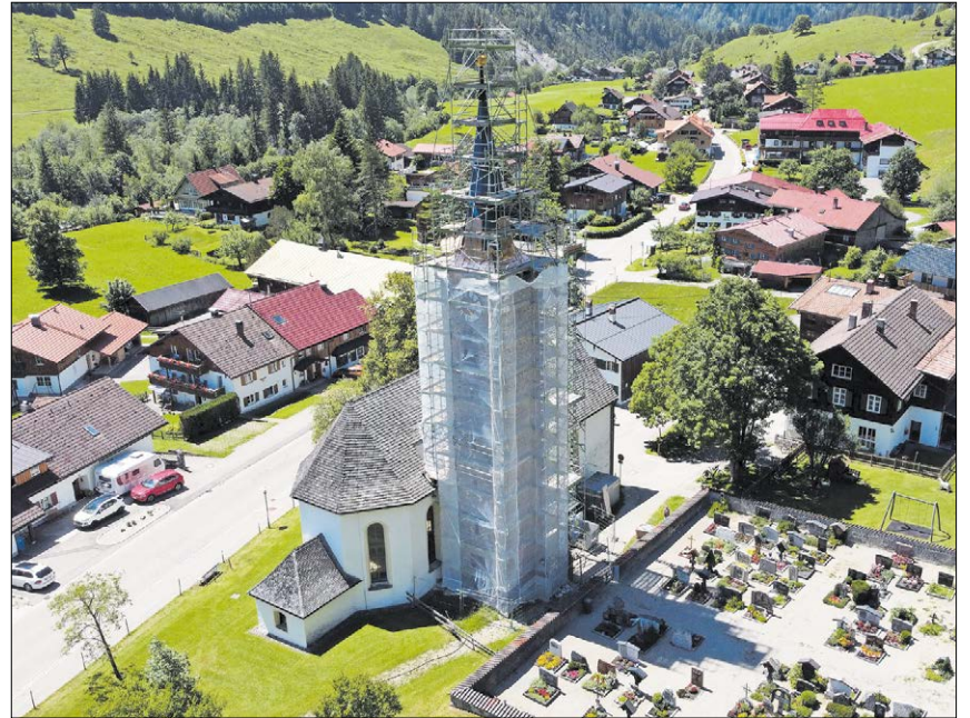
▲ Ausbrechende Mörtelfugen und undichte Stellen machten die Sanierung notwendig: Zum Kirchweihfest war der Turm von St. Antonius eingerüstet. Fotos: Wechs
