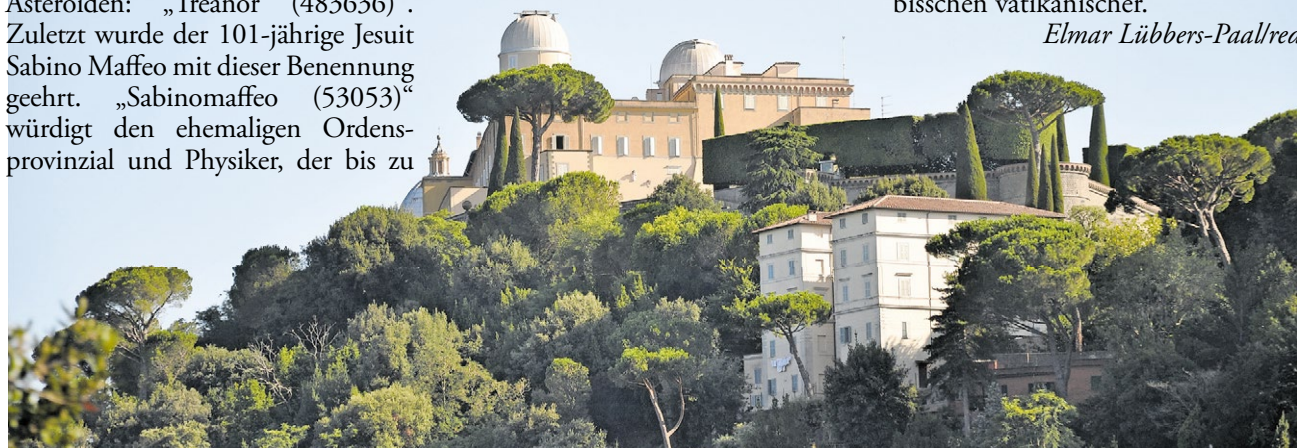
▲ Die beiden Kuppeln der Vatikanischen Sternwarte überragen die päpstliche Sommerresidenz Castel Gandolfo.
