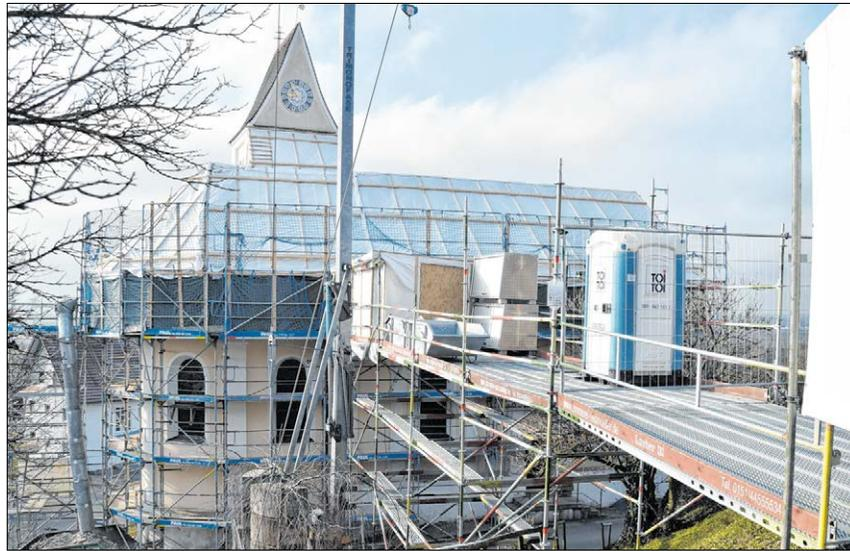
▲ Dank einer 25 Meter langen Notbrücke in luftiger Höhe kann der Dachstuhl von Sankt Nikolaus zeitsparend saniert werden. Foto: Kustermann
