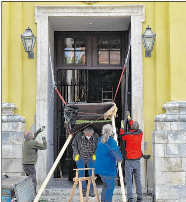
◀ Stangen, Seile und eine Flaschenzugkonstruktion halfen, die je 150 Kilogramm schweren Türflügel des Hofkirchenportals wieder einzuhängen.
