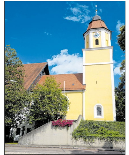
▲ Die wichtigsten Etappen ihrer Baugeschichte sind an der Kirche St. Stephan selbst ablesbar. Foto: Mohr
