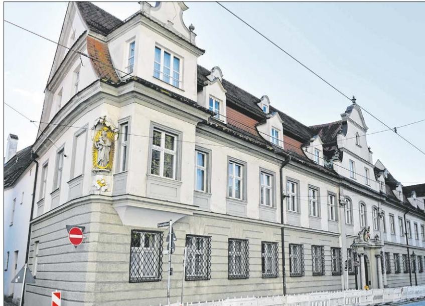
▲ Das Bischofshaus, hier eine Ansicht von Westen, ist sanierungsbedürftig. Der Erker zum Kustosgässchen (links) hat sich bereits abgesenkt. Nach dem Öffnen des Bodens im Inneren wurden verfaulte Balken gefunden. Foto: pba/Nicolas Schnall
