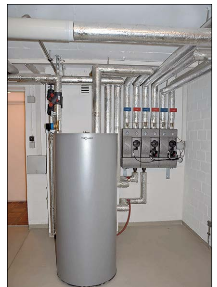
▲ So platzsparend sind heute Energieanlagen: Die Rohre und der Kessel im Keller für die Fernwärme. Foto: M. Bauer
