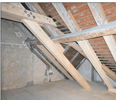
▲ Ein Blick auf den Dachboden der Pfarrkirche zeigt die Sanierung: Von den intakten alten Balken heben sich die neuen hellen, mit glänzenden Schrauben versehenen deutlich ab. Fotos: Gah
