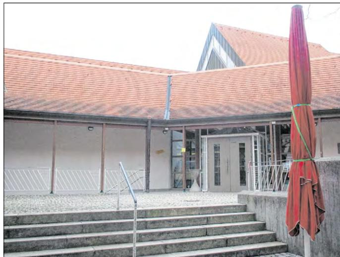
◀ Der Abgang ins Untergeschoss gleich neben dem Eingangsportal wird geschlossen, die Wand darüber geöffnet. Die neue, verglaste Wand steht dann an der Stelle der Holzfeiler.
