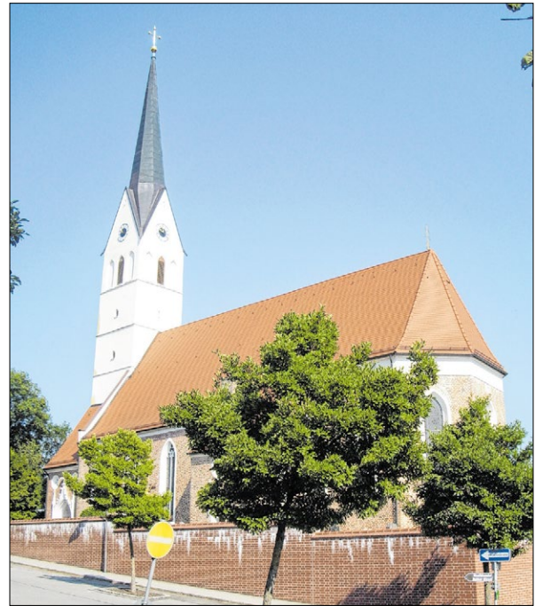
▲ Die Pfarrkirche St. Stephan in Massing präsentiert sich als spätgotischer Rohziegelbau. Foto: Mohr
